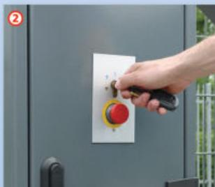
Przełącznik zewnętrzny umożliwia sterowanie bramą osobie stojącej przy słupku poprzez przekrećcie kluczyka w prawo lub w lewo.
